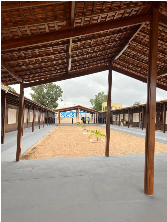
Casas de Madeira:
