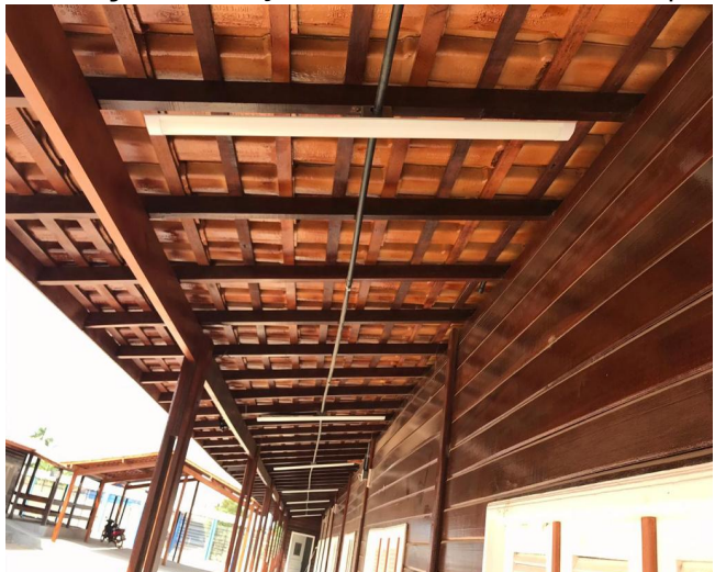
Iluminação: Instalação luminárias em led de sobrepor
