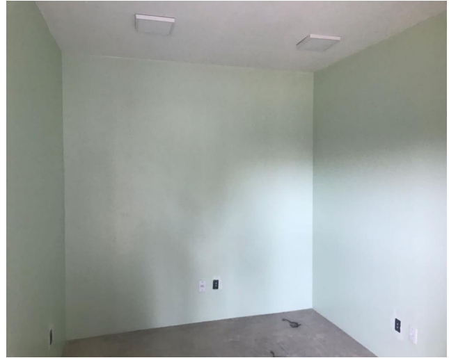
Casas de Madeira :Pintura com tinta latex em divisoria de gesso acartonado
